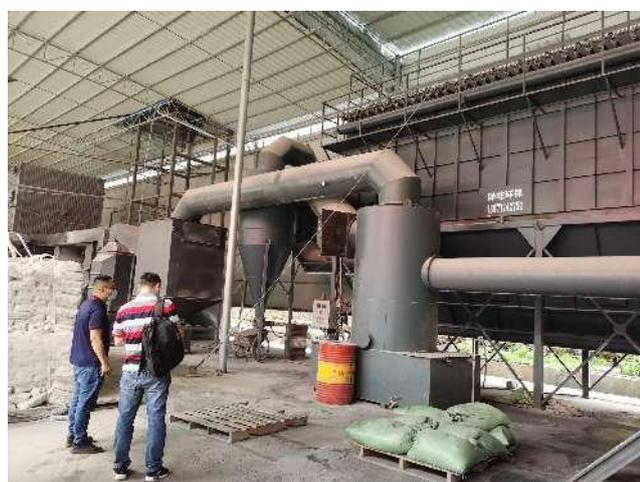
旋风除尘器+布袋除尘器（锅炉区）
